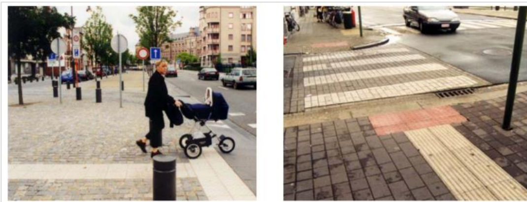
Figuur 20: Noppentegels met een kunstmatige geleidelijn (uitgevoerd in ribbeltegels) aan oversteekplaatsen (Bron: Vlaamse Overheid, 2003)
